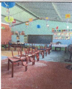
Foto1: Sustitucion de lamina por lamina troquelada calibre 26
