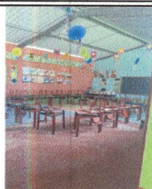
Foto2: Sustitucion de lamina por lamina troquelada calibre 26
