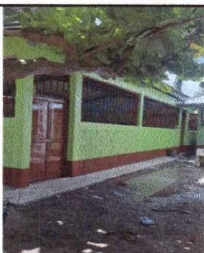
Foto 3: Reparación y levantado de muro de Block
