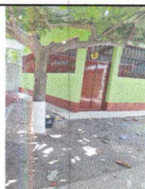
Foto 4: Reparación y levantado de muro de Block
